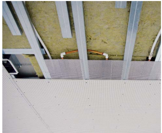
Aufbau Gipsdecke mit Kühl-/Heizregister
