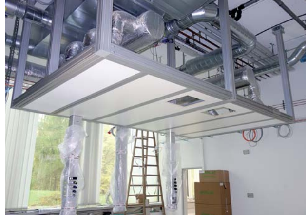
Laminarauslässe in Versuchslabor
