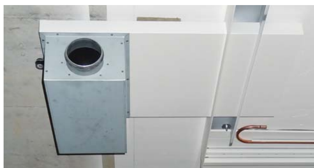
Luftanschlusskasten mit integriertem Telefoneschalldämpfer
