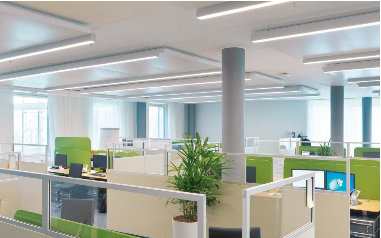
Medienschliessung über Betondecke
