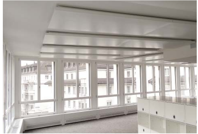
Module in Trapezform, architektonisch an Gebäudeform angepasst
