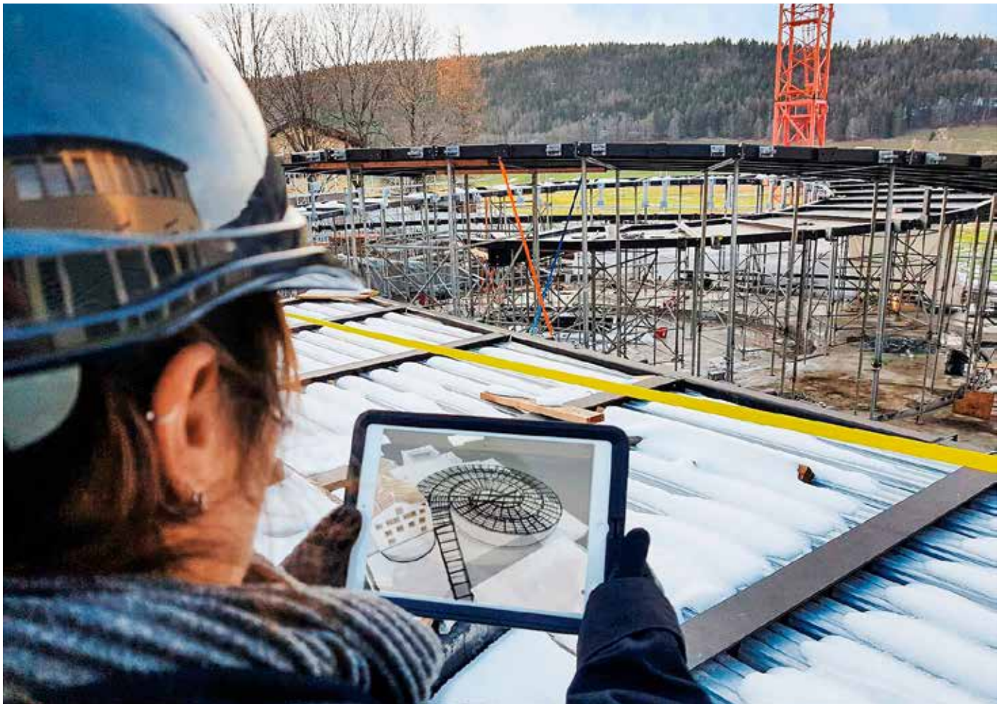
Le Musée Atelier Audemars Piguet est d'une complexité architecturale et technique insoupçonnée. Sans l'apport du BIM, il aurait été très difficile à construire, d'autant plus qu'ingénieurs et architectes devaient rester en contact permanent entre le chantier du Brassus, les bureaux CCHE à Lausanne, ainsi que les cabinets BIG à Copenhague et New York.
